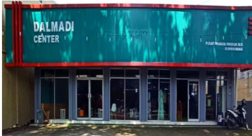
Gedung Dalmadi Center
